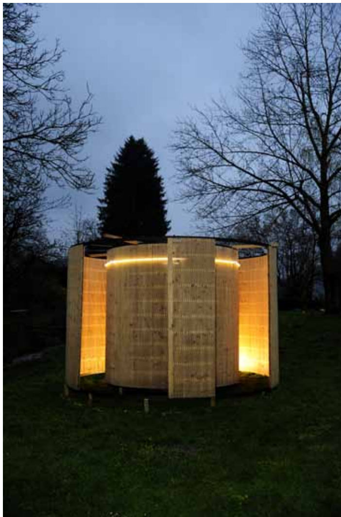
Small Labyrinth 2013 CNC gefräste 3-Schichtplatten mit Stahlringen L 410 x B 410 x H 250 cm Kreisdurchmesser 410 cm
